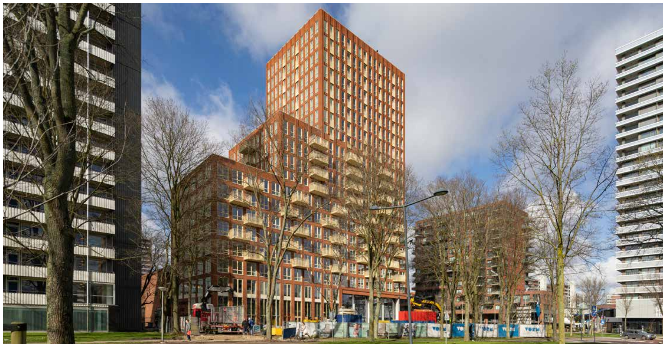
Het hoogbouwproject aan de Martinus Nijhofflaan is voorzien van een decentraal klimaatsysteem.
