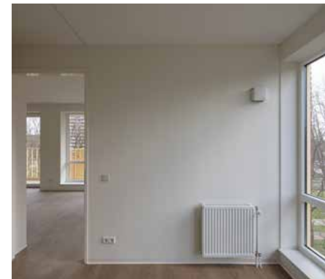
Extern rooster voor ventileren tweede ruimte t.b.v. Ventura V1D unit.
