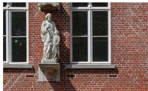
Buitenroosters verwerkt in de monumentale gevel.
