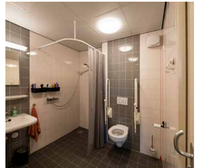
In de badkamer wordt lucht afgezogen op basis van vocht en aanwezigheid.
